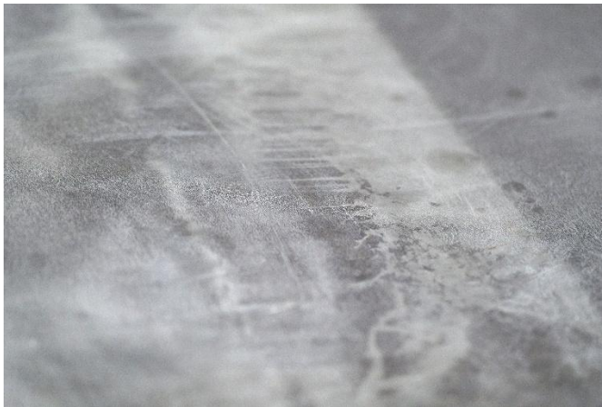
Abb. 3 Gebrauchtes, chemisch entlacktes Dach mit verzinkter Oberfläche: bereit für eine zweite Nutzung. © Fraunhofer IWU
